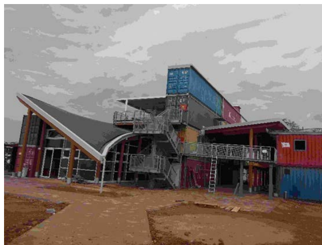
Une vue de l'infrastructure principale du complexe
